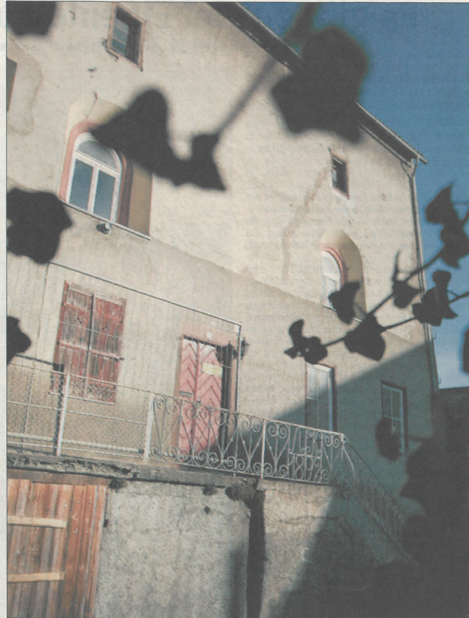
Im März sollen die Sanierungsarbeiten am Klösterle beginnen.
